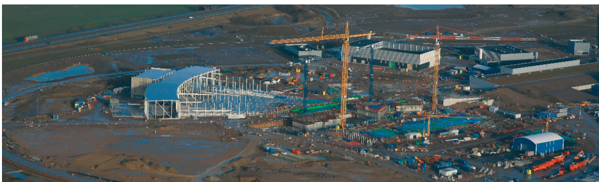
Foto 8. Volop activiteiten in december 2017 op de site in Lund, Zweden nu de bouw in volle gang is.
