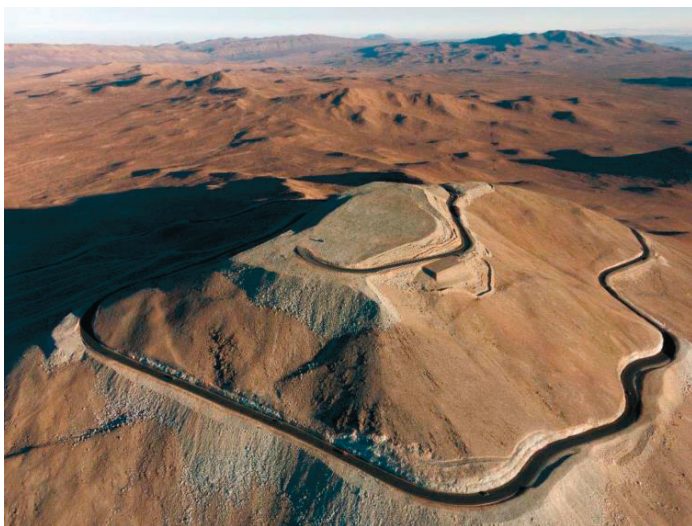
Foto 7. De toegangsweg en het platform voor de ELT op de berg Armazones in het noorden van Chili in de Atacama woestijn. Op 19 juni 2017 werd officieel gestart met de bouw van de ELT.
