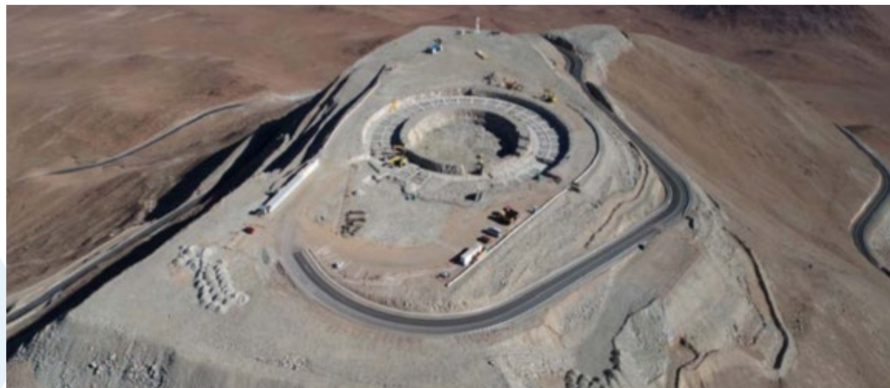
Foto 1: November 2018, het werk aan de fundamente van de ELT is in 2018 flink gevorderd (Credit: ESO).
