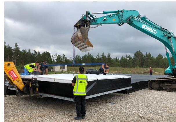
Plaatsing van de LOFAR High-Band antennes (foto: R Pauliks/VUAS, Latvia)
