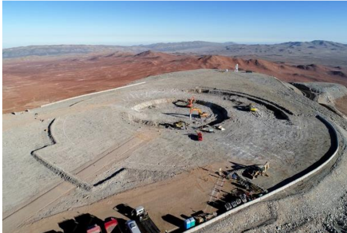
ELT – fundering voor telescoop en gebouw in Chili zijn uitgegraven
